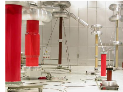
Img.: High Voltage Lab, ETH Zurich
